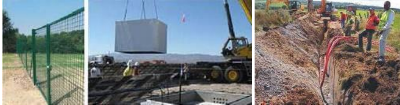
Illustration 73 : Exemple de chantier d'un parc photovoltaïque au sol
